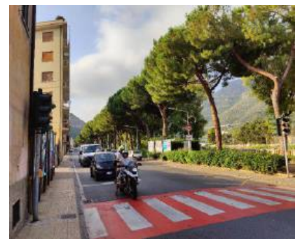
LUNGO ARGENTINA il tratto stradale in causa
